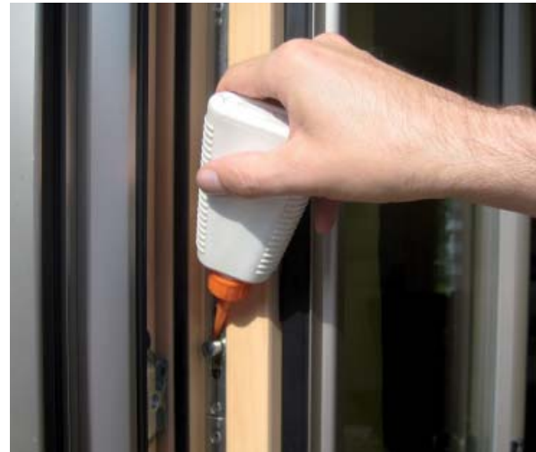
Bild 6 Regelmäßiges Fetten der Beschläge erhöht die Nutzungsdauer eines Fensters. Fotoquelle: ift Rosenheim
